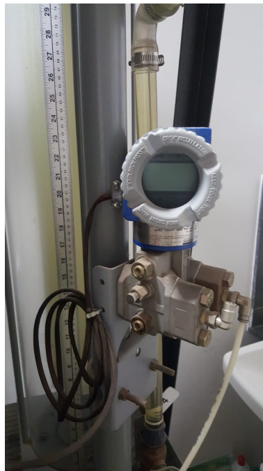
Figura 2.4: Foto do sensor de nível instalado na planta.
