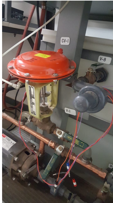
Figura 2.3: Foto da válvula de controle CV-1 e seu sensor de posição instalados na planta de nível.
