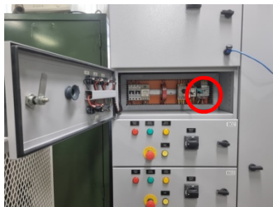
Figura 3 – Configuração interna da gaveta B01 do CCM. Em destaque, o relé eletrônico E1 Plus.
